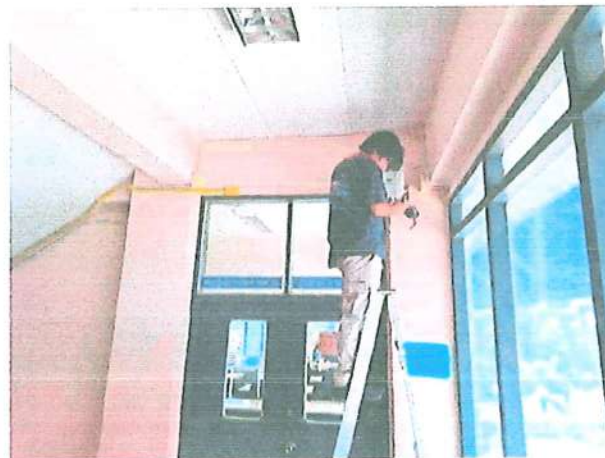
Access point จุดที่ 4 ติดตั้งที่ชั้น 2 หน้าห้อง 421
