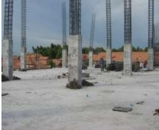
การใช้พลาสติกห่อเสาหลังจาก แกะแบบออก เพื่อเป็นการป้องกันความชื้น ระเหยออกจากคอนกรีตเป็นการบ่มคอนกรีต
