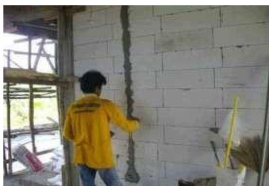
การทำแนวฉาบปูนเพื่อควบคุม ไม่ให้ผิวหน้าเป็นลูกคลื่น
