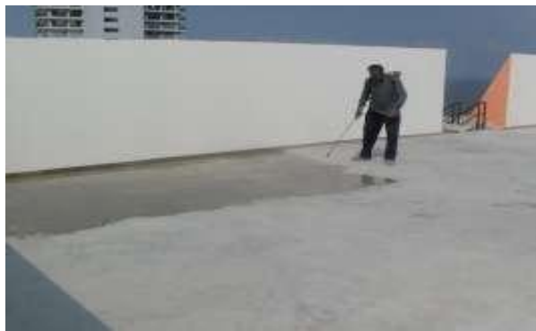
การใช้น้ำยาพ่นเคลือบผิวหน้าเพื่อ กันความชื้นระเหยตัวเป็นการบ่มคอนกรีต อีกวิธีหนึ่ง
