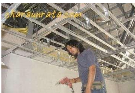
การวางโครงคร่าวลูมิเนียมเพื่อ ติดตั้งฝ้าประเภทบอร์ดซึ่งเป็นวัสดุเบา
