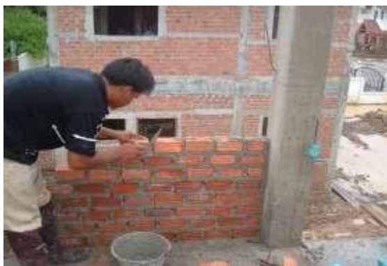
การก่ออิฐมอดูต้องเคาะให้อิฐแต่ละ ก้อนมีระดับหลังอิฐเท่ากัน
