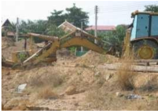
แสดงการปรับพื้นที่บริเวณที่จะทำ การก่อสร้าง โดยการกำจัดวัชพืชและวัตถุอื่นๆ ที่ไม่พึงประสงค์ต่องานก่อสร้าง
