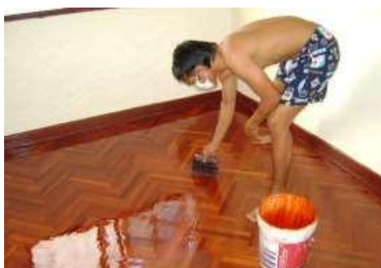
การย้อมสีผิวไม้และเคลือบเงา
