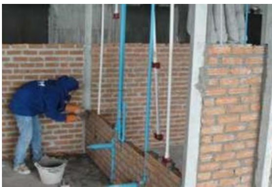
การเดินท่อน้ำและก่ออิฐปิดทับท่อน้ำ
