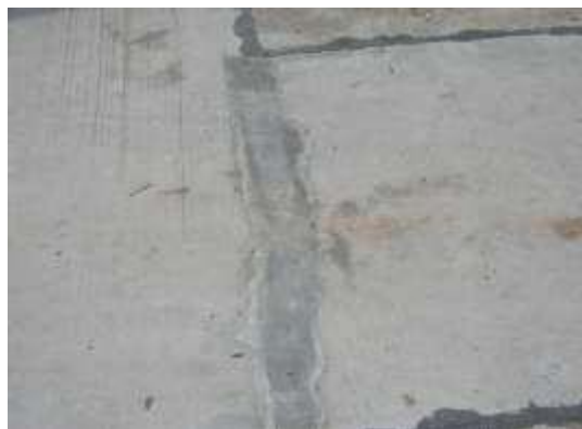
การซ่อมรอยร้าวคอนกรีตด้วย ซีเมนต์พิเศษสำหรับซ่อมรอยร้าว
