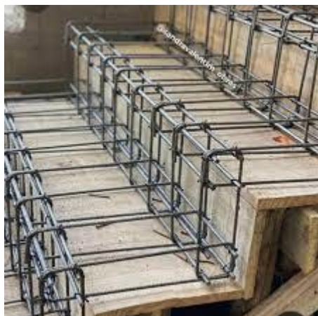
การผูกเหล็กโครงสร้างบันได คอนกรีตให้ควบคุมและตรวจตามงานโครงสร้าง
