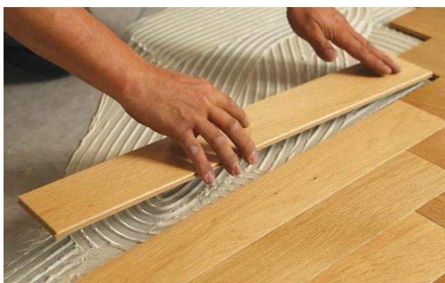
ปูพื้นไม้ปาเก้โดยใช้กาวเป็น ตัวเชื่อมประสานให้ติดกับพื้นโครงสร้าง
