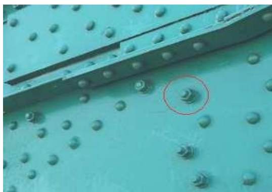
การยึดนอตในโครงสร้างเหล็ก ต้องขันให้แน่นและแนบติดกันสนิท
