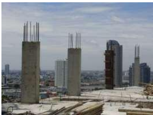
การแกะแบบเสาคอนกรีต
