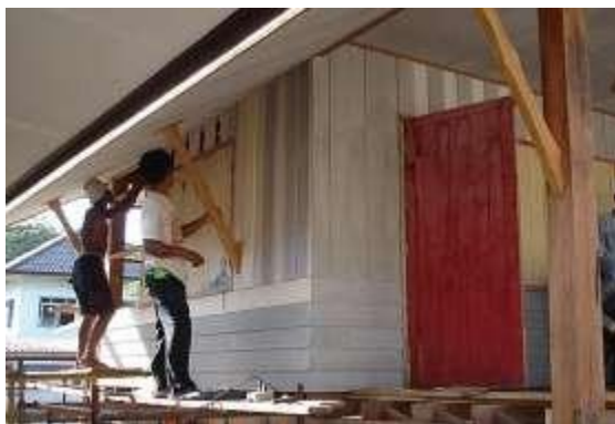
การตีฝ้าด้านล่างเป็นแบบซ้อนเกร็ด ด้านบนเป็นแบบทับแนว ที่ทำเสร็จเรียบร้อยแล้ว
