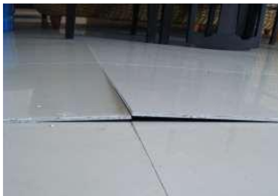
การปูกระเบื้องที่วัสดุยัดใต้ท้องกระเบื้อง ไม่เต็มแผ่น เช่น ตามมุมกระเบื้อง เมื่อน้ำหนักมาก ลงมุมใดมุมหนึ่ง ทำให้กระเบื้องหลุดและมุมด้าน ตรงข้ามลอยขึ้น
