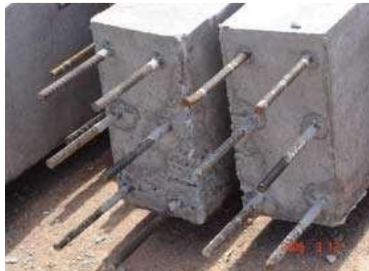
เหล็กจากคานสำเร็จรูปเป็นตัวยึด กับเสาหรือคานตัวอื่น สำหรับสอดเข้าไปใน คอนกรีตเสา
