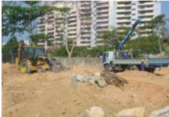
แสดงการขนย้ายวัสดุที่ไม่เหมาะสมที่ จะใช้ในงานถม ในบริเวณที่จะทำการก่อสร้าง ซึ่งผู้รับจ้างจะต้องนำวัสดุไปทิ้งใน ณ ตำแหน่ง ที่คณะกรรมการตรวจการจ้างกำหนด
