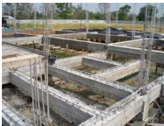
การเว้นช่องสำหรับสอดเหล็กพื้น ในการเทพื้นที่หลัง
