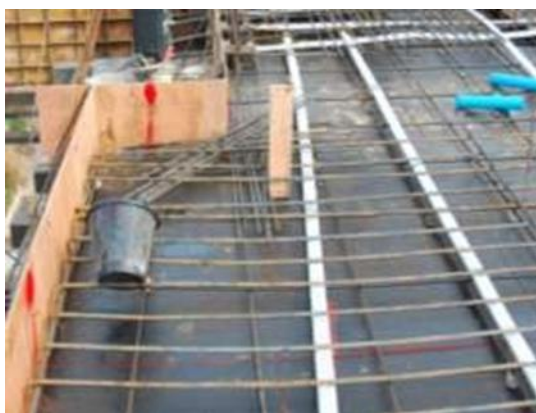
แบบเทคอนกรีตต้องมีระดับ อ้างอิง (สีแดง) ก่อนเทคอนกรีต
