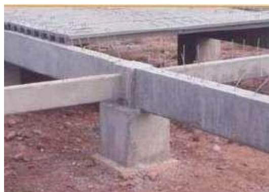
หลังจากเชื่อมรอยต่อแล้วต้อง ตกแต่งให้เรียบร้อย
