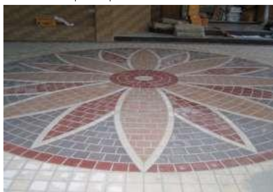
การจัดลวดลายปูกระเบื้องที่สลับซับซ้อน ต้องควบคุมและตรวจให้ถูกต้องตาม Shop Drawing ที่ได้รับอนุมัติไว้
