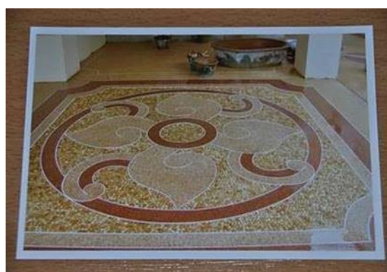
การปูหินขัดภายในอาคารแบบ ตกแต่งลวดลาย
