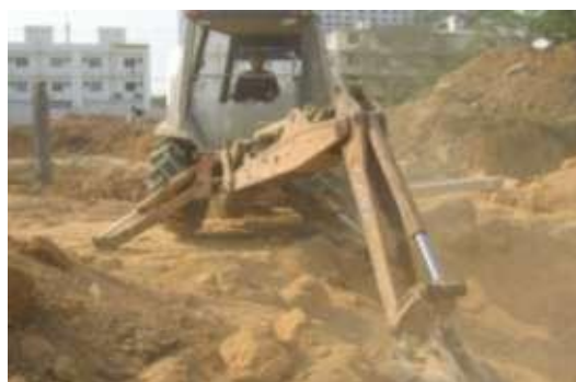
แสดงการขุดดินโดยใช้รถขุดดิน ที่มี ขนาดเหมาะสมกับพื้นที่ที่จะทำการขุดดิน
