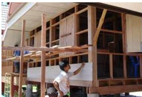
โครงไม้จริง ไม้ฝาเป็นไม้เชอร์รา ส่วนใด หน้าต่างเป็นการวางโครงตีฟ้าไม้สำหรับซ้อนแกร็ด ด้านบนเป็นการวางโครงสำหรับติดตั้ง ฝาแบบทับแนว
