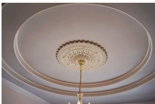
การตกแต่งฝ้าเพดานเล่นระดับเป็นลวดลาย ซับซ้อนหลายชั้น ด้วยวัสดุประเภทบอร์ด ที่สามารถดัดโค้งได้
