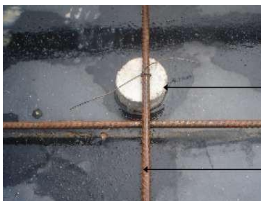
การหนุนลูกปูนก่อนเทคอนกรีต ให้ได้ระยะ Covering ถูกต้องตามแบบ
