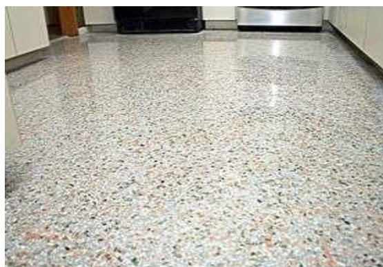
การปูหินขัดภายในอาคารแบบ ลวดลายแบบเดียวตลอดทั้งห้อง
