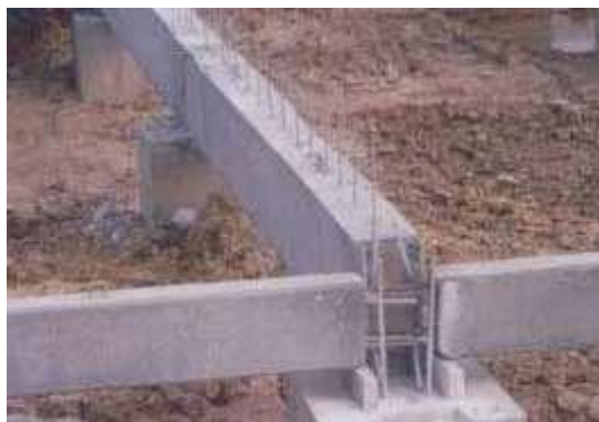
การเชื่อมรอยต่อระหว่างคานต้องเท คอนกรีตเพื่อเชื่อมต่อกัน
