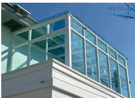
การติดตั้งกระจกกรองแสงใช้เป็น หลังคา
