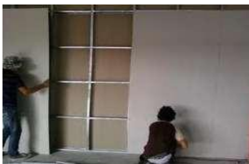
การติดตั้งผนังวัสดุบอร์ดที่ใช้ทำ ผนังยึดติดกับโครงซี่ลาย
