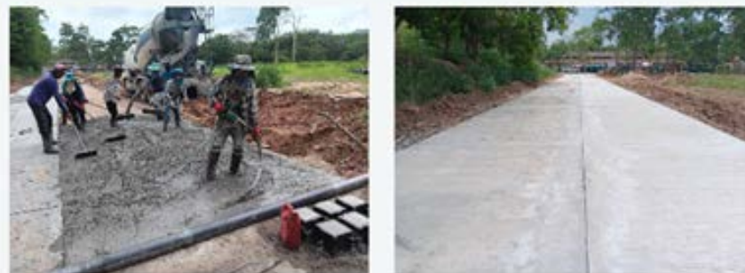
ถนนคอนกรีต (งบกองทุนไฟฟ้า)
