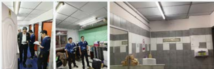
ปรับปรุงห้องน้ำและพื้นที่ติดอำนวยการ
