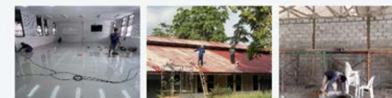
ปรับปรุงอาคารแผนกช่างก่อสร้าง
