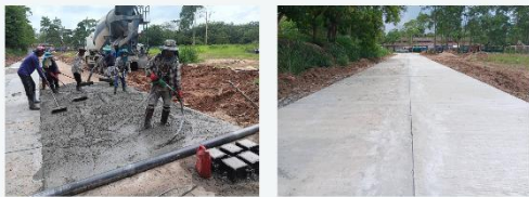
ถนนคอนกรีต (ขบกองกุนไฟฟ้า)
