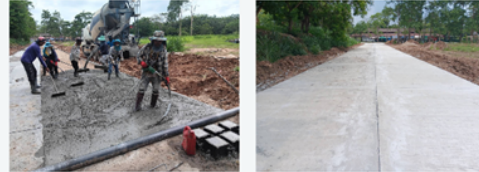
ถนนคอนกรีต (จบกองทุนไฟฟ้า)
